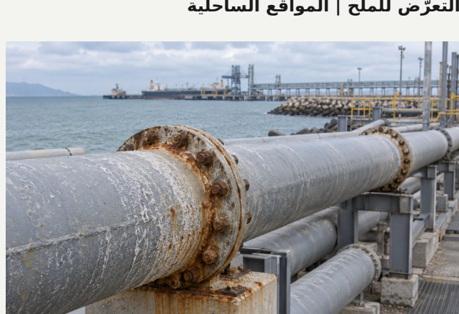
هواء محمّل بالملح. أسطح الأنابيب الخارجية تتآكل.
