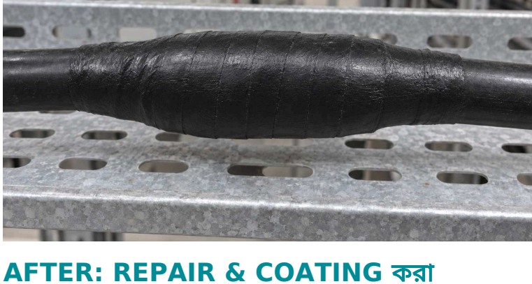
AFTER: REPAIR & COATING করা
