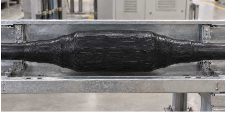
AFTER: REPAIR & COATING করা
