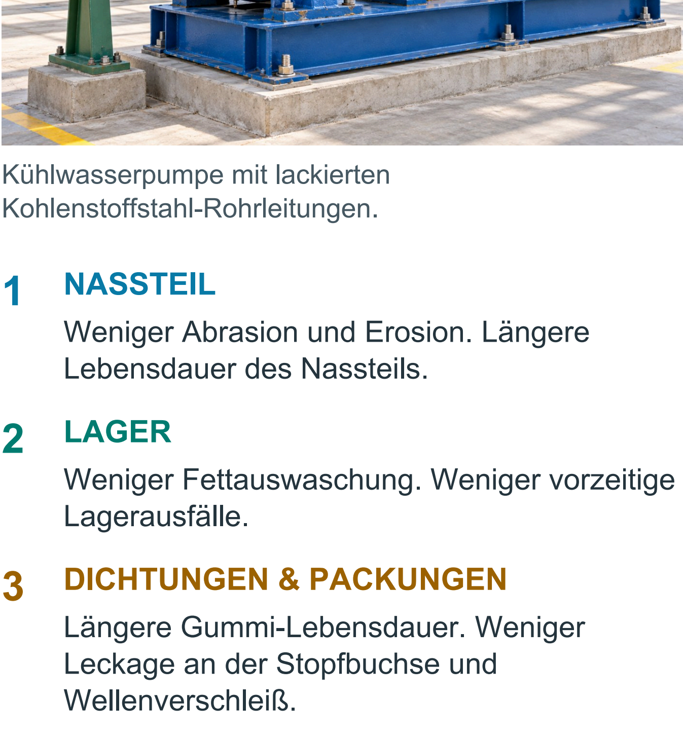
Kühlwasserpumpe mit lackierten Kohlenstoffstahl-Rohrleitungen.
