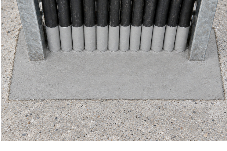
FM-71 / Bodenabdichtung mit Mörtel
