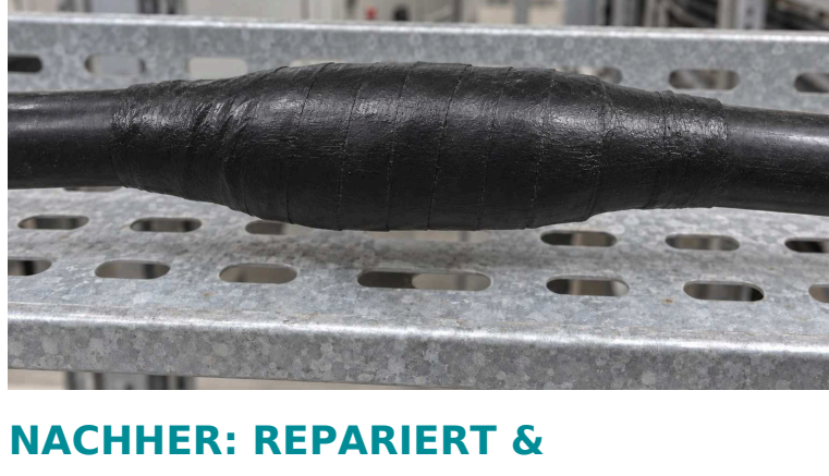
NACHHER: REPARIERT & BESCHICHTET
