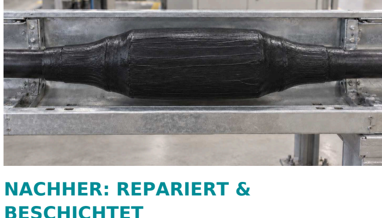
NACHHER: REPARIERT & BESCHICHTET
