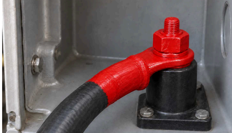
NACHHER: REPARIERT & BESCHICHTET
