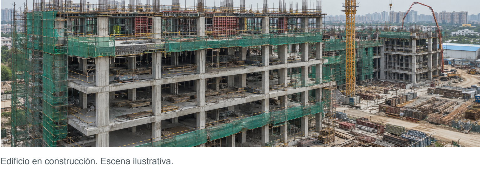
Edificio en construcción. Escena ilustrativa.
