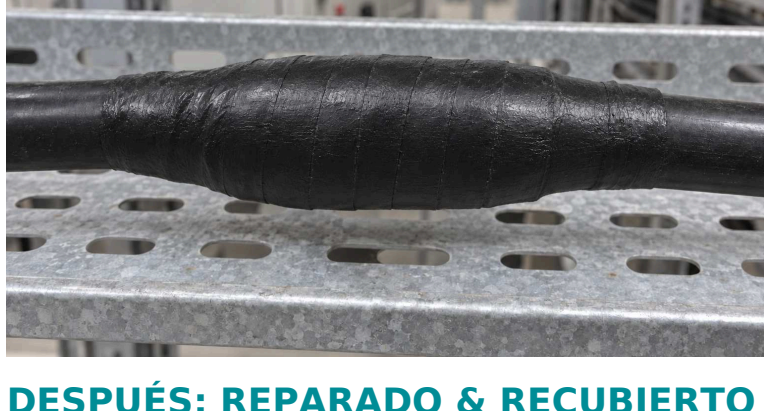
DESPUÉS: REPARADO & RECUBIERTO
