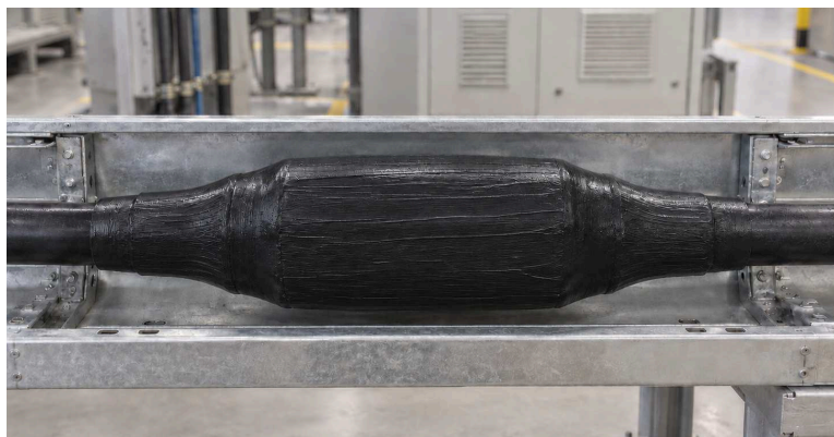
DESPUÉS: REPARADO & RECUBIERTO
