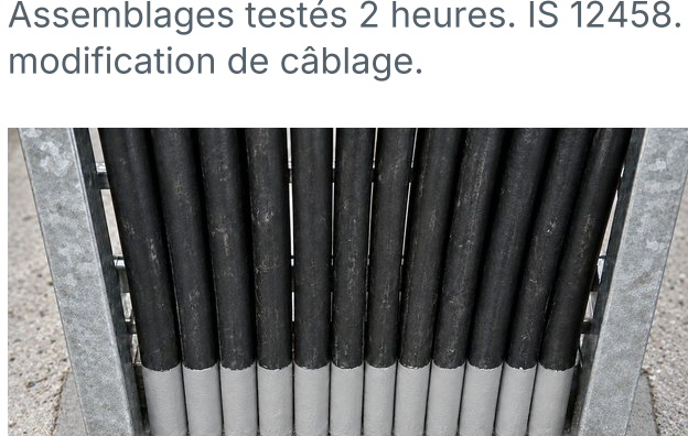
FM 71 · Calfeutrement de plancher au mortier
