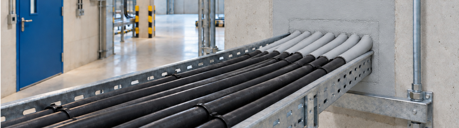
Ouverture calfeutrée + câbles revêtus : les deux voies de propagation du feu sont traitées. Illustration d'installation.
