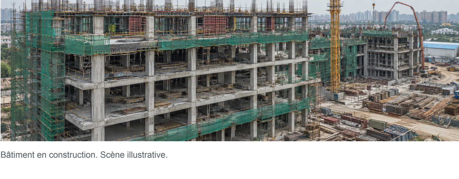
Bâtiment en construction. Scène illustrative.
