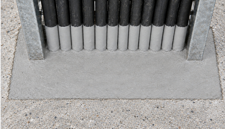
FM-71 / Coupe-feu de plancher en mortier
