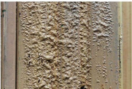
Cloques : sel piégé sous le film
