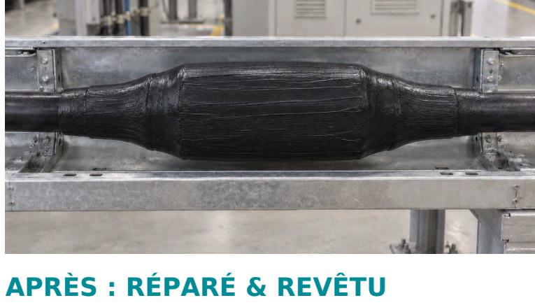
APRÈS : RÉPARÉ & REVÊTU
