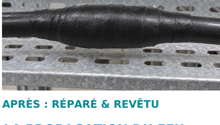
APRÈS : RÉPARÉ & REVÊTU
