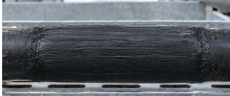
APRÈS : RÉPARATION 931B LOCALE
