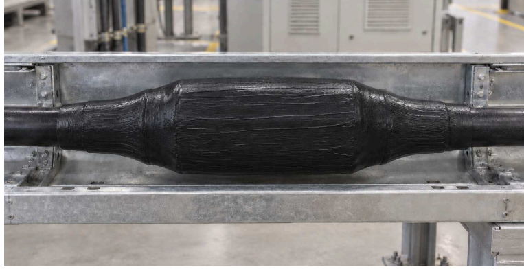
बाद में: REPAIR & COATING
