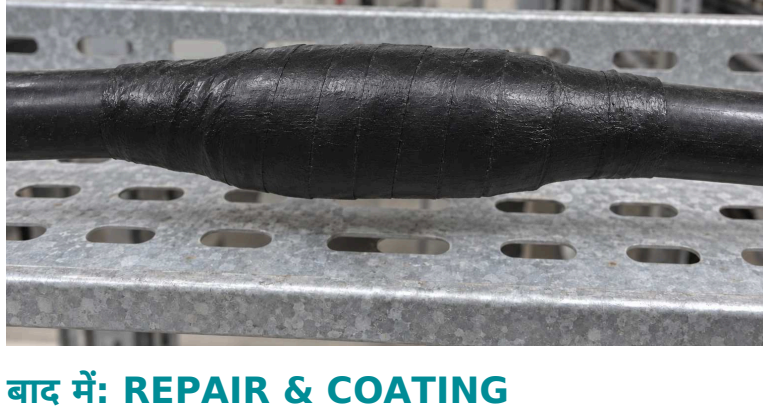
बाद में: REPAIR & COATING
