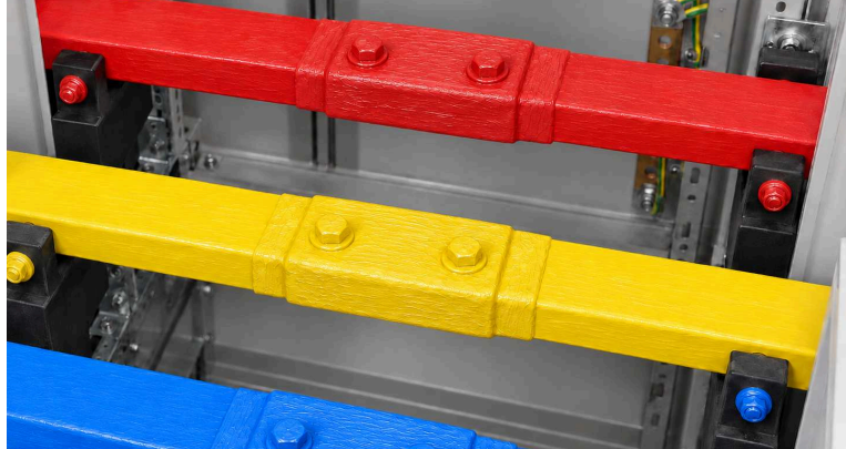
बाद में: JOINT & BOLTS COATED
