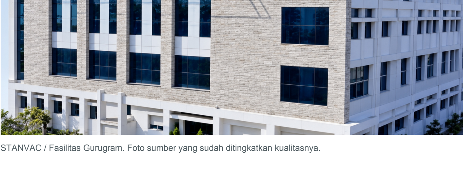
STANVAC / Fasilitas Gurugram. Foto sumber yang sudah ditingkatkan kualitasnya.
