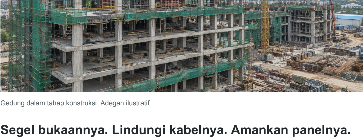
Gedung dalam tahap konstruksi. Adegan ilustratif.
