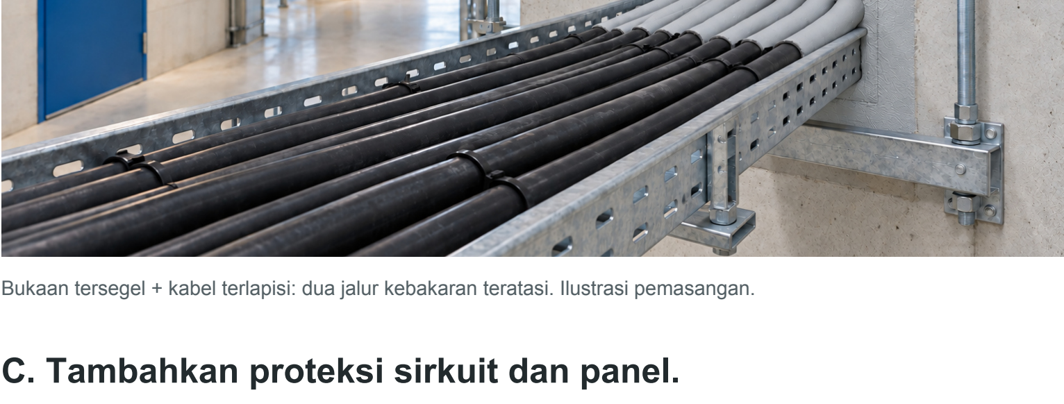
Bukaan tersegel + kabel terlapis: dua jalur kebakaran teratasi. Ilustrasi pemasangan.
