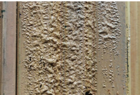
Gelembung: garam terjebak di bawah lapisan
