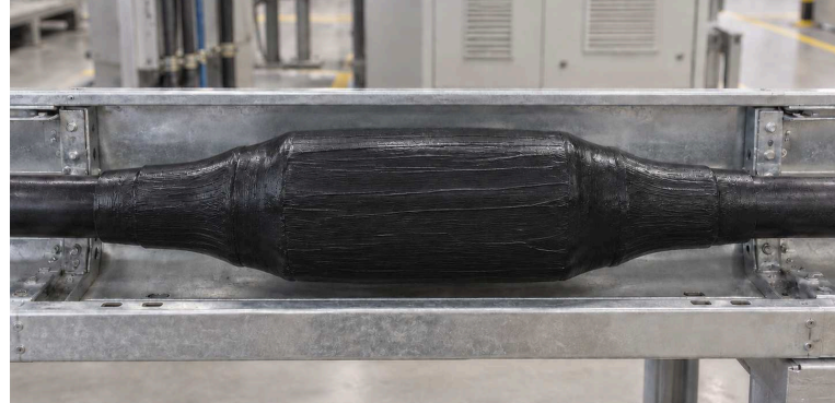
SESUDAH: DIPERBAIKI & DILAPISI
