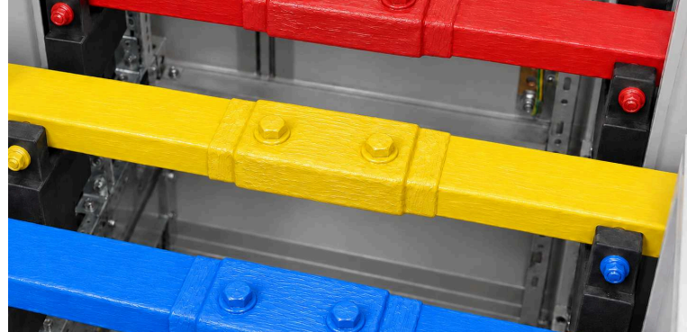
SESUDAH: SAMBUNGAN & BAUT DILAPISI
