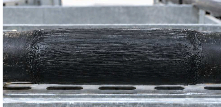
SESUDAH: PERBAIKAN LOKAL 931B
