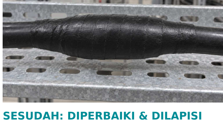
SESUDAH: DIPERBAIKI & DILAPISI
