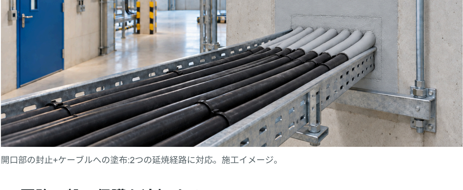
開口部の封止+ケーブルへの塗布:2つの延焼経路に対応。施工イメージ。
