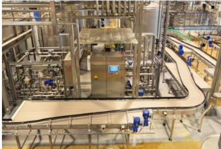
露出した製品の上の鋼材—研掃材は決して飛散させられない
