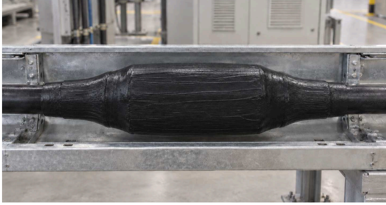
施工後：補修 & 塗布済み
