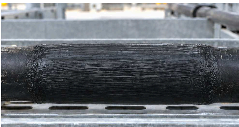
施工後：931B で部分補修
