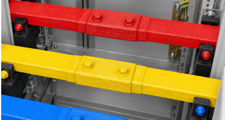
施工後：接続部 & ボルト塗布済み
