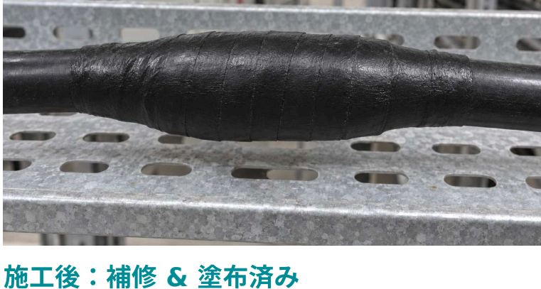
施工後：補修 & 塗布済み
