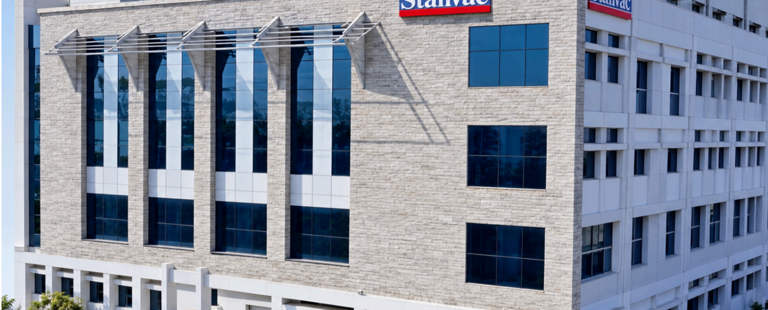
STANVAC / 구루가온 공장. 보정된 원본 사진.
