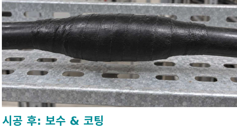
시공 후: 보수 & 코팅
