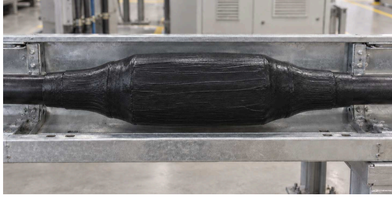
시공 후: 보수 & 코팅
