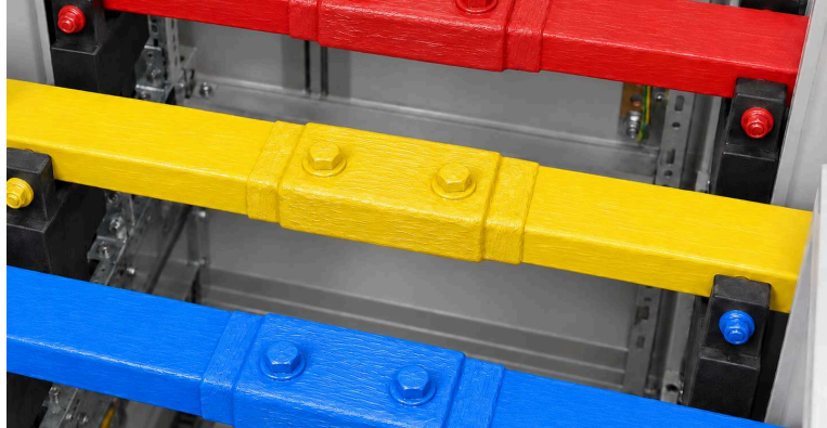
시공 후: 접속부 & 볼트 코팅
