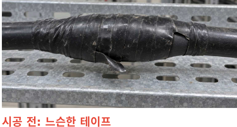
시공 전: 느슨한 테이프
