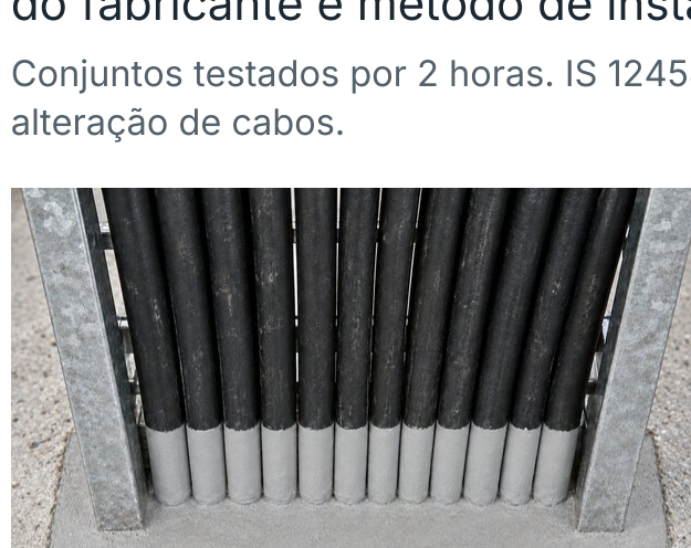
FM 71 · Vedação de piso com argamassa
