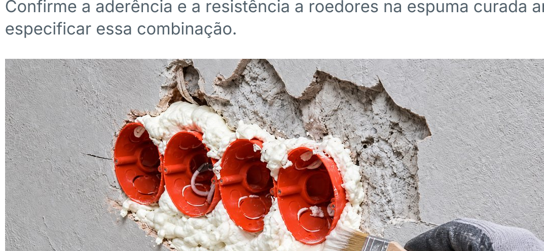
Protege o isolamento. Mantém as cores dos cabos visíveis.
