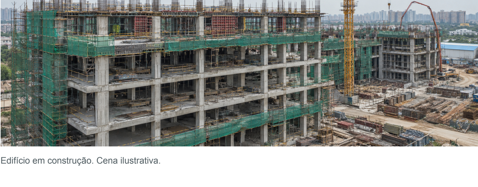
Edifício em construção. Cena ilustrativa.
