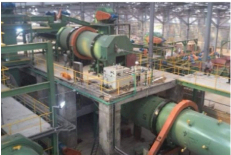
Ar carregado de sal — aço da torre de prilagem
