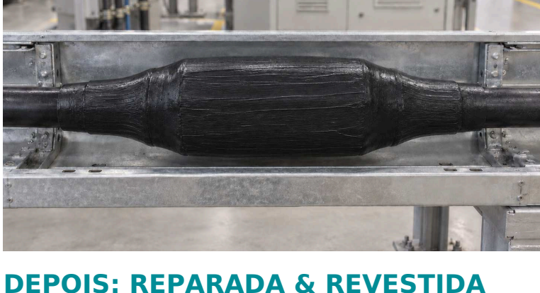
DEPOIS: REPARADA & REVESTIDA
