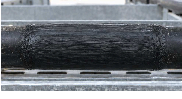
DEPOIS: REPARO LOCAL 931B
