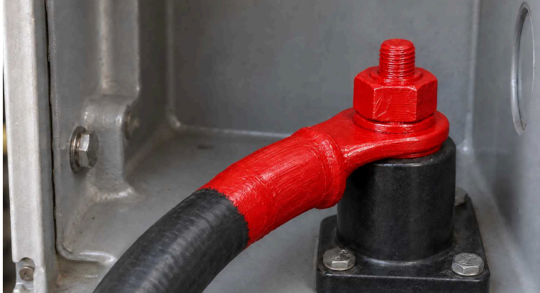
DEPOIS: REPARADA & REVESTIDA
