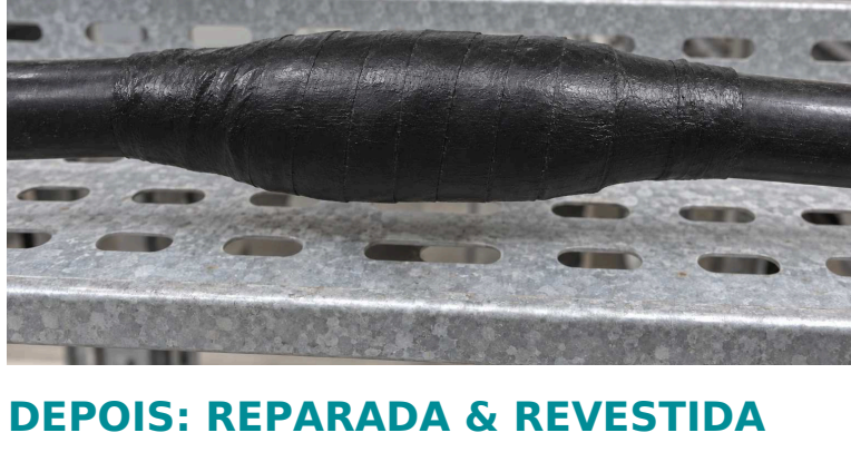
DEPOIS: REPARADA & REVESTIDA
