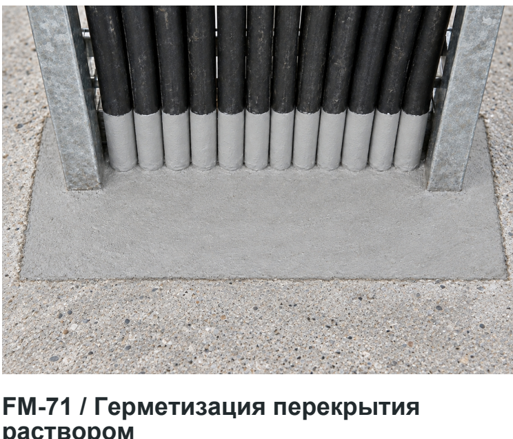
FM-71 / Герметизация перекрытия раствором
