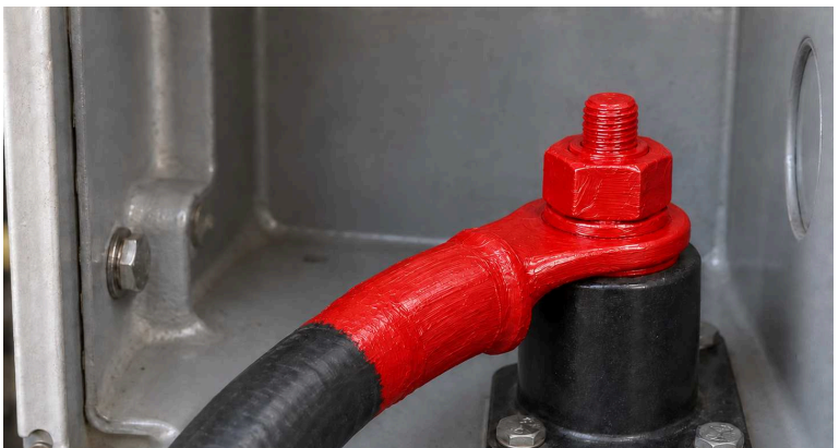
ПОСЛЕ: РЕМОНТ & ПОКРЫТИЕ
