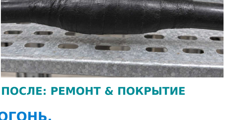
ПОСЛЕ: РЕМОНТ & ПОКРЫТИЕ
