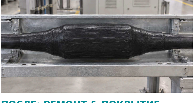
ПОСЛЕ: РЕМОНТ & ПОКРЫТИЕ
