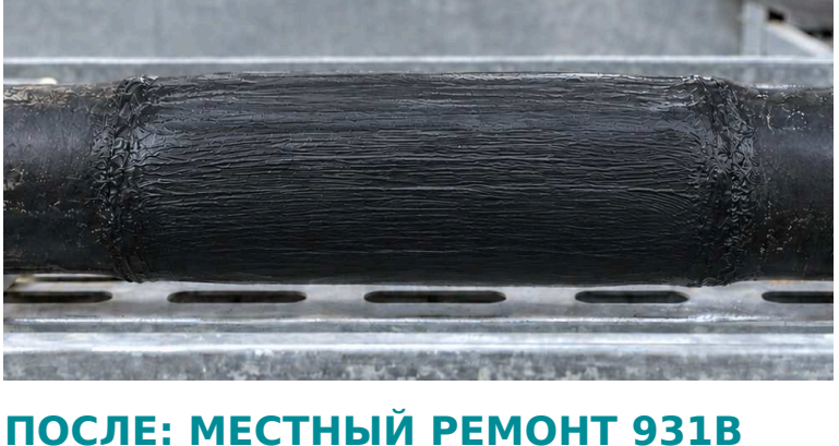
ПОСЛЕ: МЕСТНЫЙ РЕМОНТ 931B
