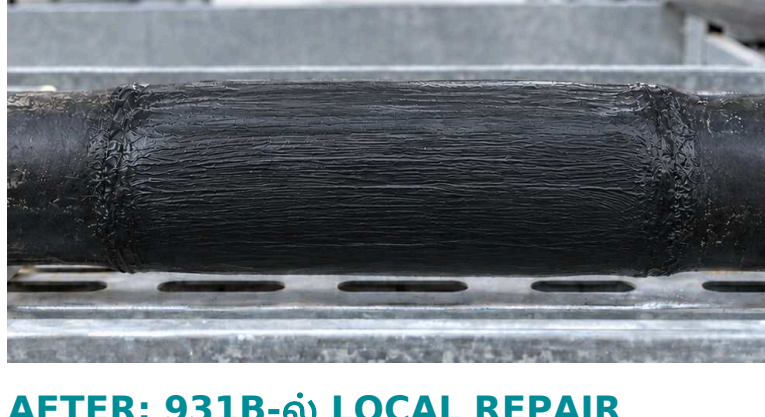
AFTER: 931B-ல் LOCAL REPAIR
