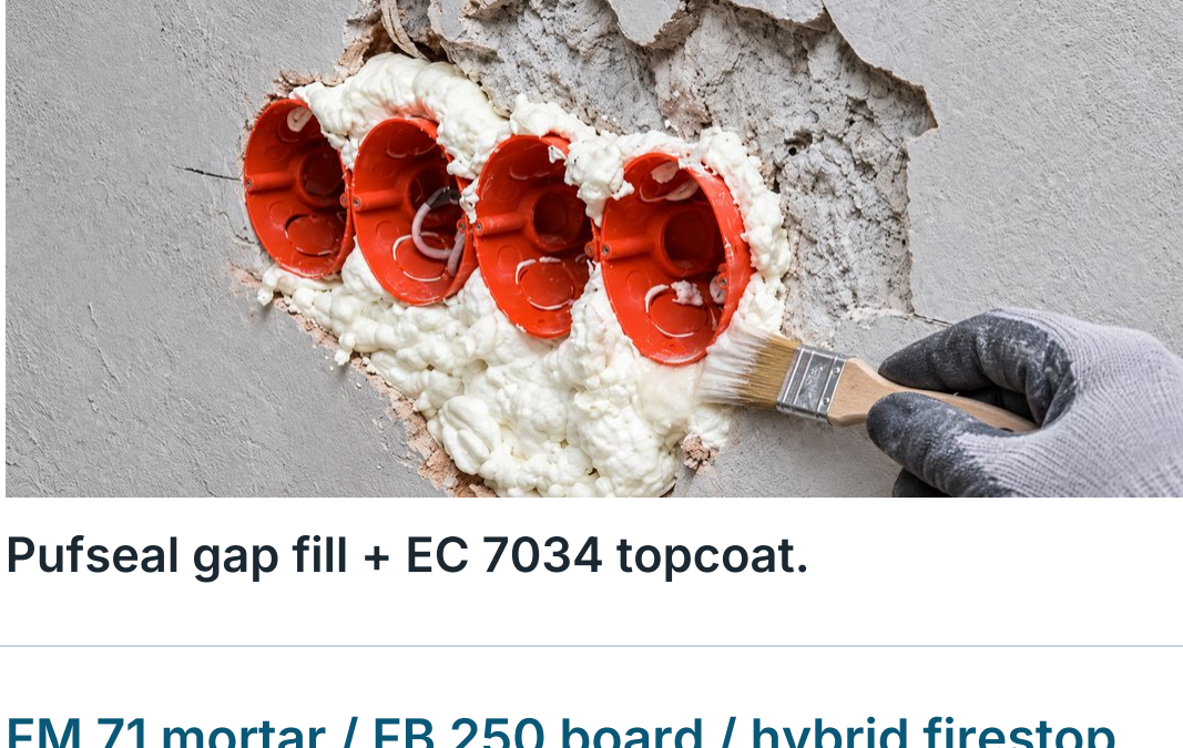
Pufseal gap fill + EC 7034 topcoat.
