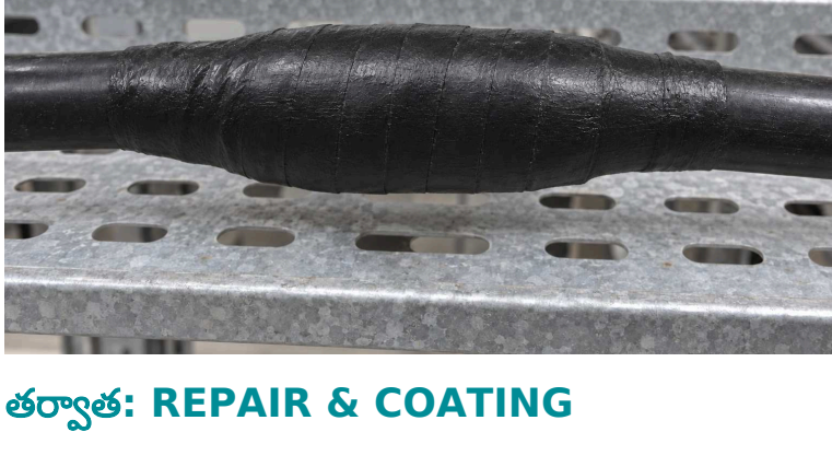
తర్వాత: REPAIR & COATING
