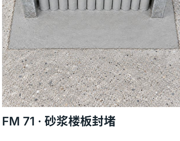
FM 71 · 砂浆楼板封堵
