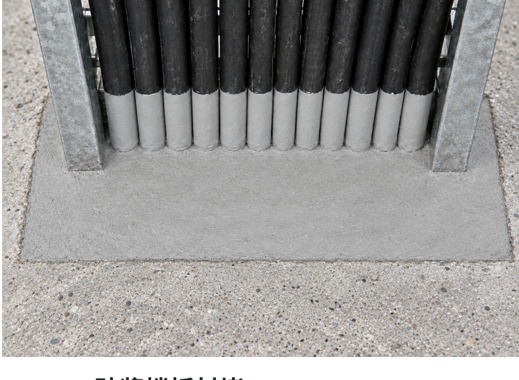
FM-71 / 砂浆楼板封堵
