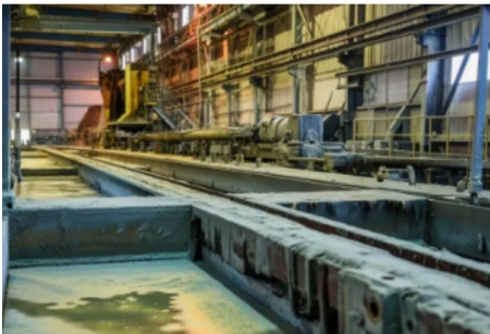
酸雾侵蚀——酸洗车间
