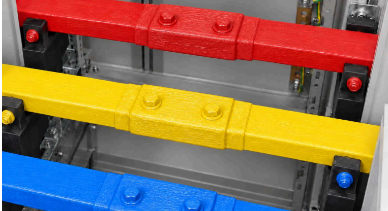
处理后：接头 & 螺栓已涂刷
